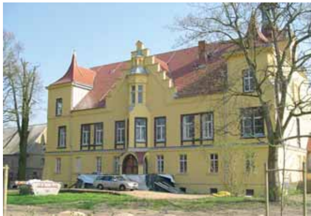
von außen bereits ein augenschmaus: die renovierung des schlossinneren tat dringend not.
