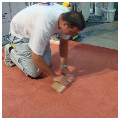
bodenbelag sorgfältig flächig einlegen und mit dem korbrett anreiben – fertig!
