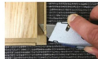
Wenn Ausrichten nicht möglich ist oder eine Rückwärts-Verlegung notwendig wird: Entfernen Sie den Vorsprung im Profil und verwenden Sie Holzleim, um die Dielen zu verbinden.
