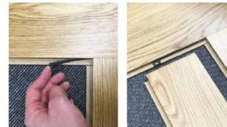
Wenn eine Diele verriegelt ist, können Sie sie nicht mehr aufnehmen Falls doch notwendig, verwenden Sie den mitgelieferten Entriegelungsstift. Schieben Sie ihn so weit wie möglich in die Nut. Er drückt die flexible Feder zurück und klinkt die Diele aus, sodass Sie sie aufnehmen können. Heben Sie die Diele an ihrer langen Seite mit etwas Kraft nach oben.
