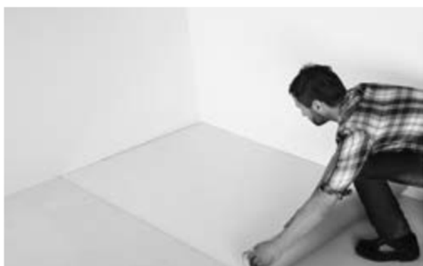
Abb. 1: Die erste Bahn VINYL SK mit der Abdeckfolie nach oben von einer Raumecke aus entlang einer Wand komplett ausrollen. (Alternativ kann die Verlegung auch von der Raummitte aus erfolgen.)
